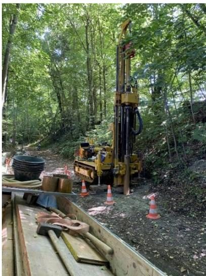
Les piézomètres ont été installés le long du Chemin Creux, ces tubes permettent d'accéder à l'eau de la nappe phréatique et d'en relever le niveau piézométrique.
